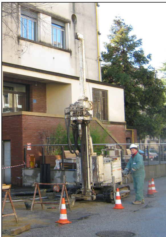
Perforatrice su punto di sondaggio
